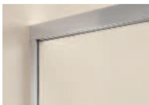
En option, le vantail fixe peut reposer dans des profilés d'encadrement mur ou des profilés en U pour sol, qui permettent en outre de dissimuler un éventuel interstice entre le verre et la structure bâtie.
